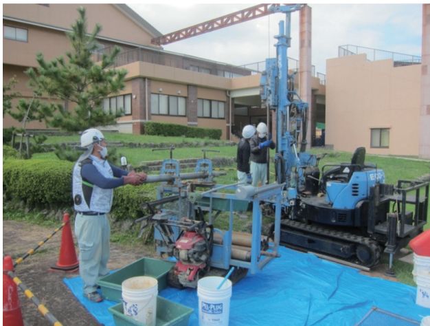
図3 富士山文化会館におけるボーリング掘削の様子
