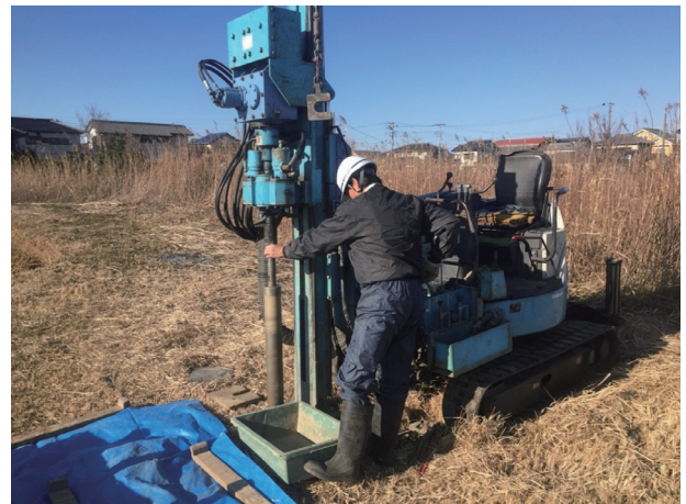
図3 エコプローブによるボーリング掘削の様子
