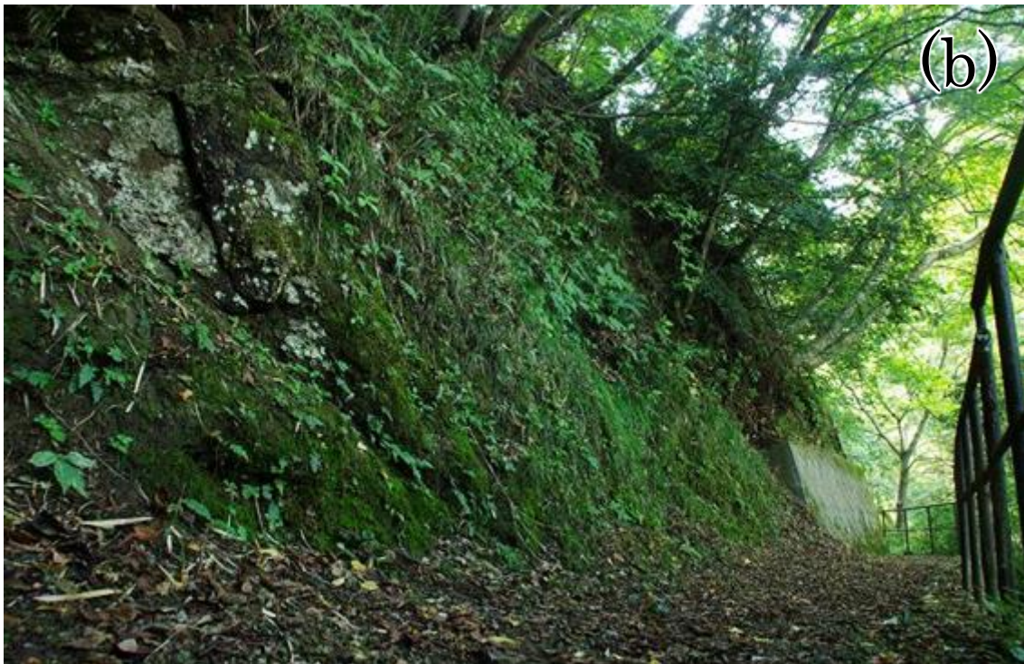
Fig. 2-6. 自然歩道調査 調査地の人工傾斜面 (a. コンクリート擁壁で覆われた人工傾斜面、b. もろい岩・土壌・自然植生で構成された人工傾斜面)
