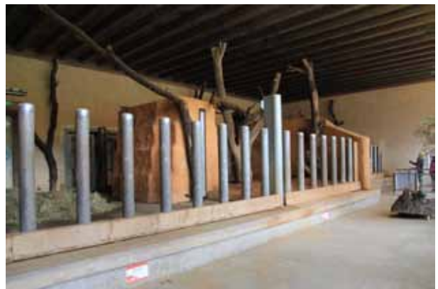
ゾウ舎を改修して、現在はインドサイを飼育している。この日は屋外の運動場に出ていた。
