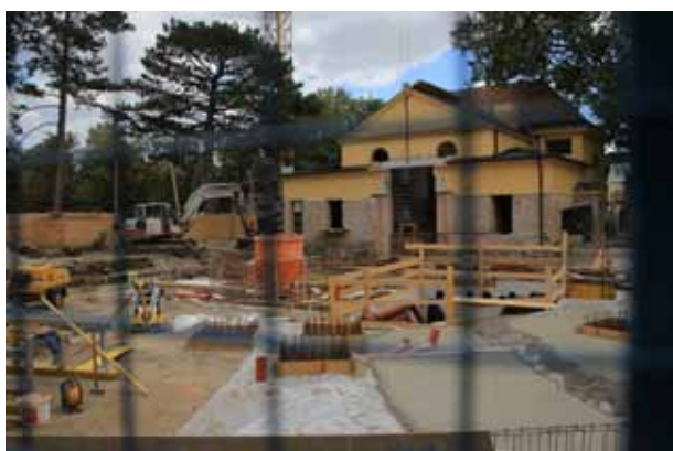
工事中のキリンの展示場。パビリオン周辺の歴史ある展示場の1つであり、建物を維持した状態でリニューアルを行っている。
