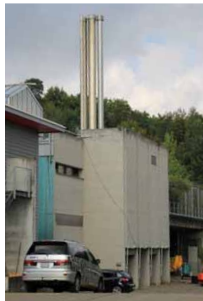
CO 2 ニュートラルを目指し、ウッドチップを燃料としたセントラル・ヒーティングシステムを導入している。
